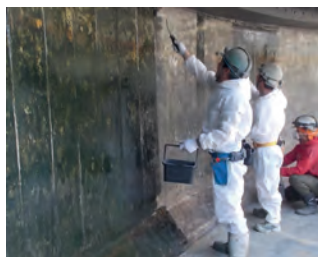
プライマー塗布工
