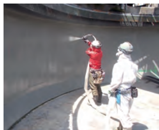
ポリウレア吹付け工
