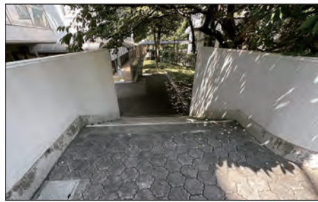
ポリサイン施工前
