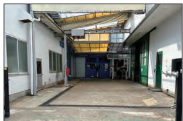
ポリウレア施工前
