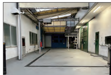
ポリウレア施工後
