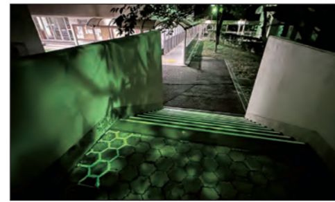
ポリサイン施工後 暗時
