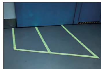
ポリサイン(ライン) 施工後 暗時
