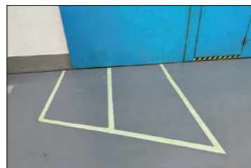
ポリサイン(ライン) 施工後 明時
